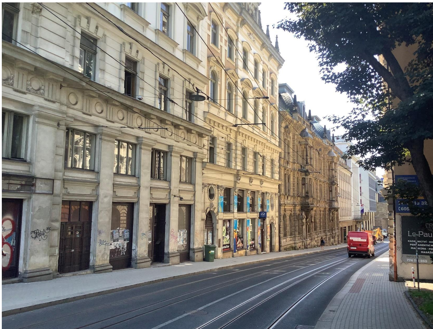
Obr. 15: Fotodokumentace zástavby v okolí kritického místa č. 4 priority I v ulici Rumunská v Liberci
