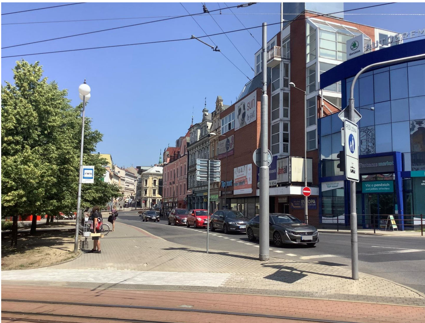
Obr. 17: Fotodokumentace zástavby v okolí kritického místa č. 4 priority I v ulici Moskevská v Liberci
